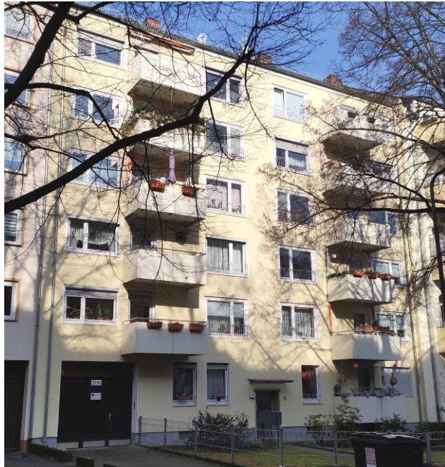
Rechts: Das Haus Rüdeshheimer Straße 31
